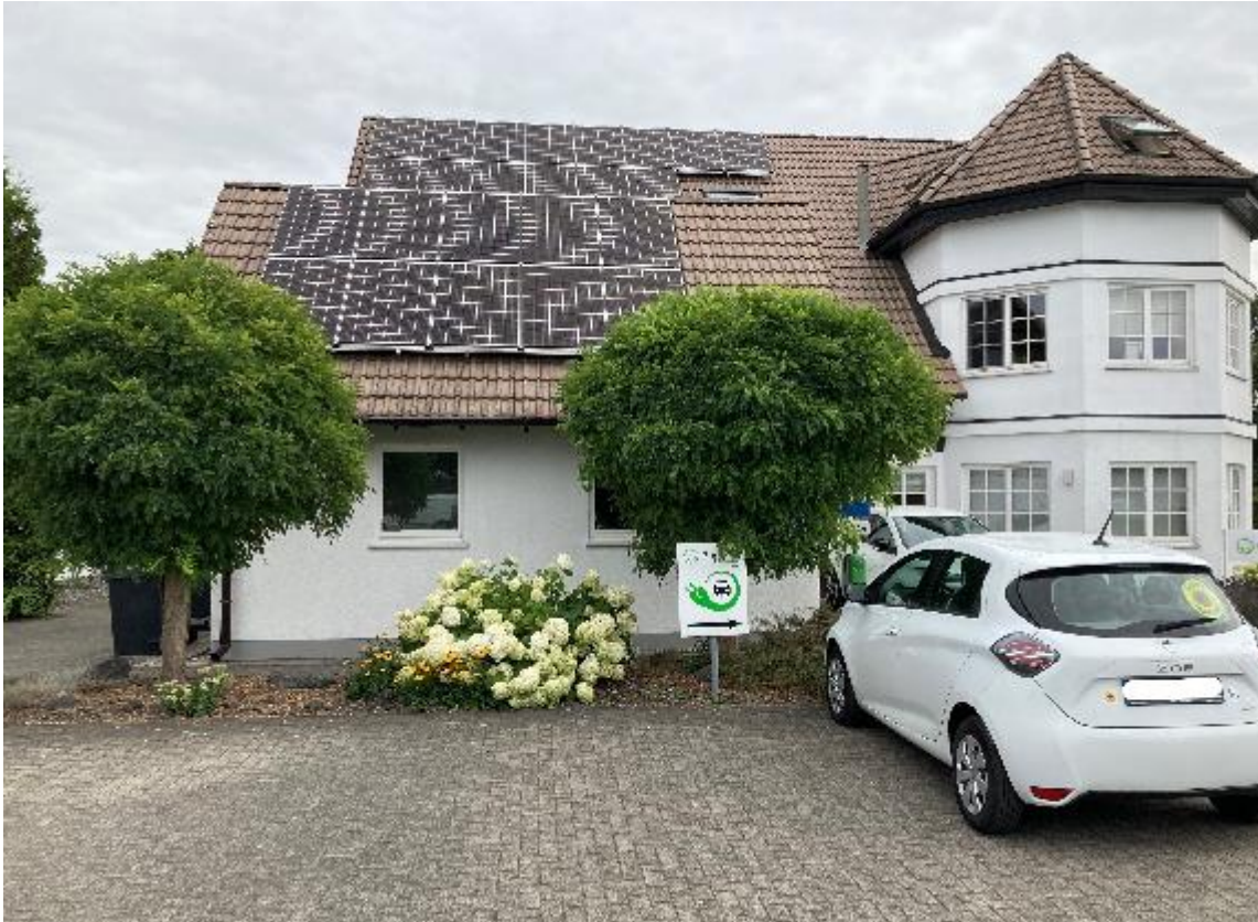
Neu installierte PV-Anlage auf dem 'B.A.U.M.-Haus', Bildquelle: Edward Herdt, B.A.U.M. Consult
